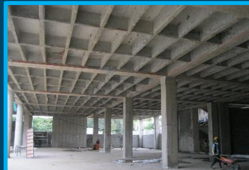
Losas Aligeradas Jardín Plaza-Cali
